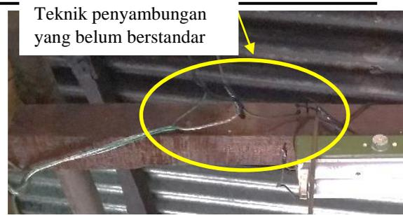
Gambar 1. Teknik Pemasangan Instalasi Listrik Rumah Tangga
